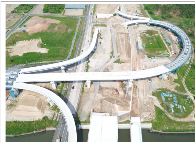
工事現場東側より撮影
