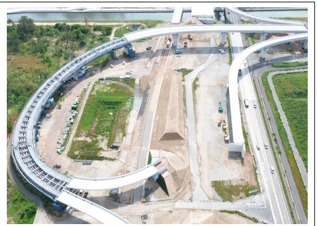
工事現場西側より撮影
