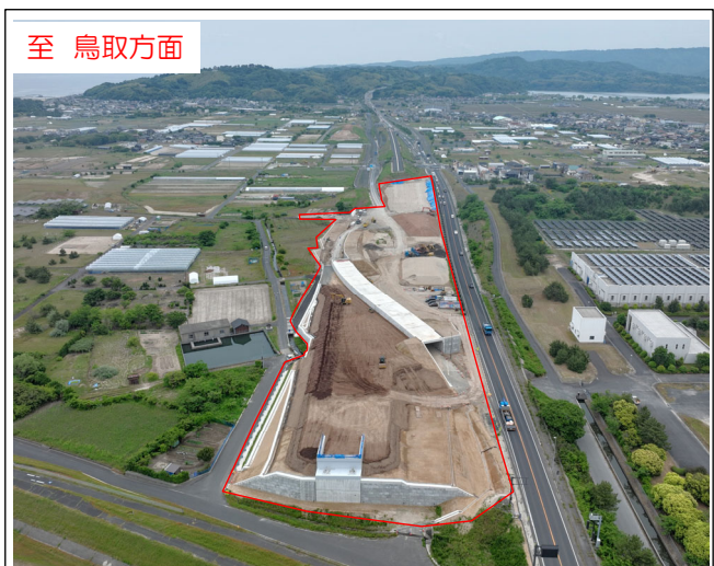
工事現場終点側より撮影
