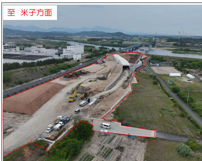
工事現場起点側より撮影
