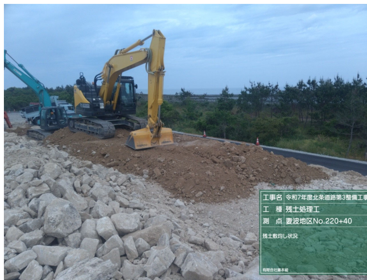
土砂受け入れ整地 整地状況
