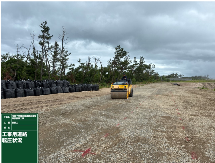
仮設工 工事用道路施工
