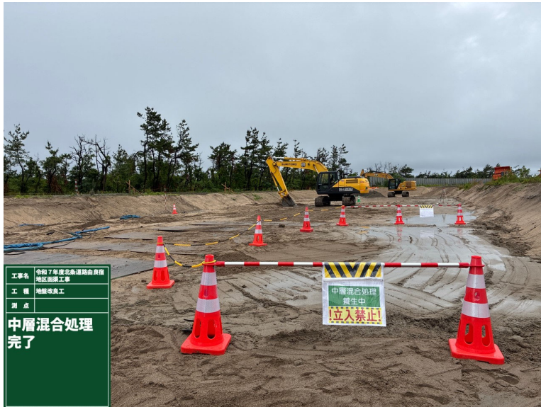
地盤改良工 中層混合処理
