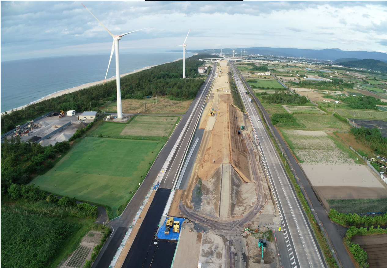
令和8年6月5日【着工前】
