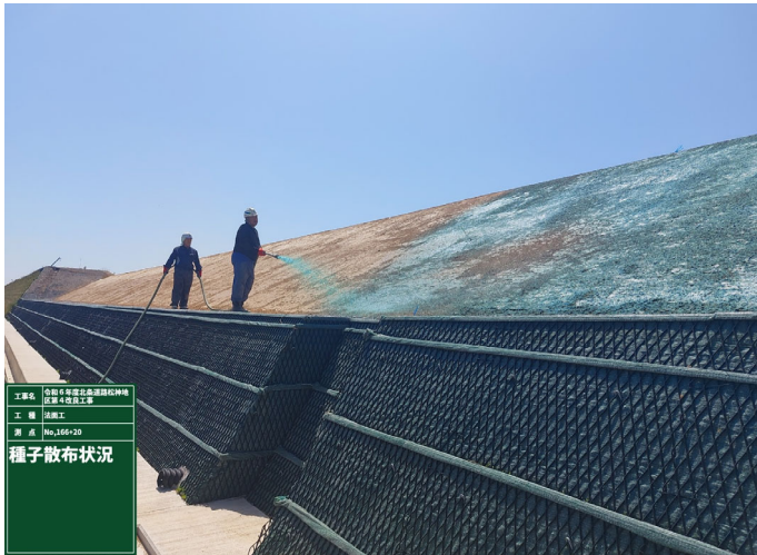
植生工 種子散布状況
