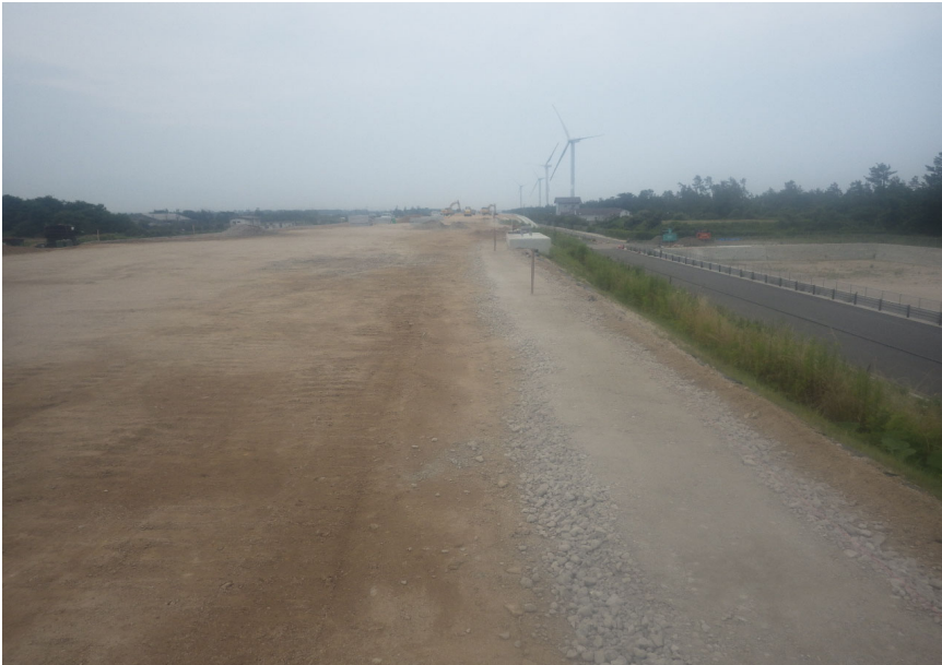
令和7年6月 No.156+00付近（上り）
