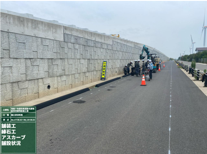
舗装工（縁石工） アスカープ舗設
