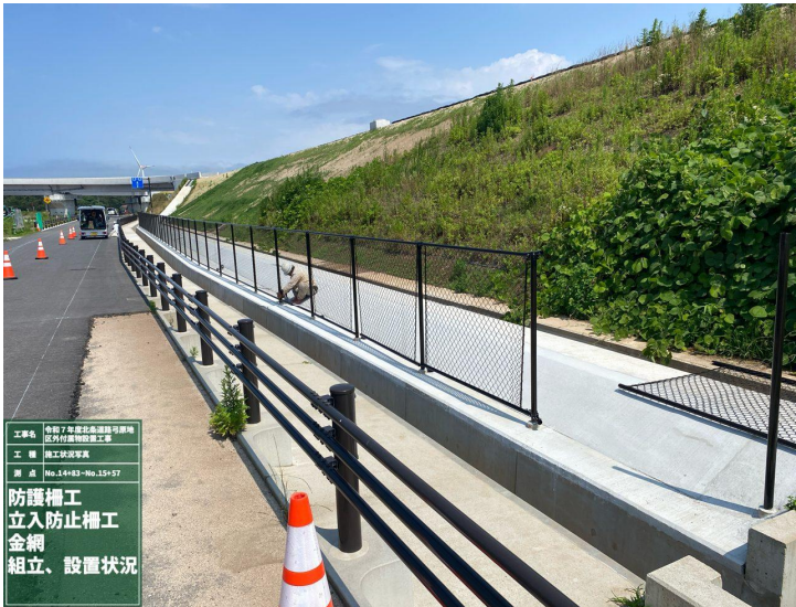
防護柵工 立入防止柵工
