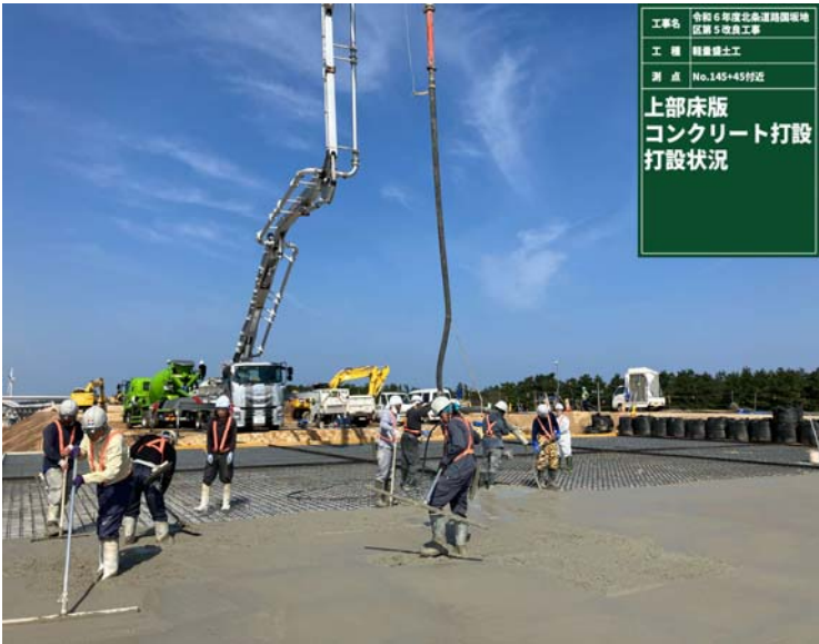
軽量盛土工 上部床版コンクリート 打設状況
