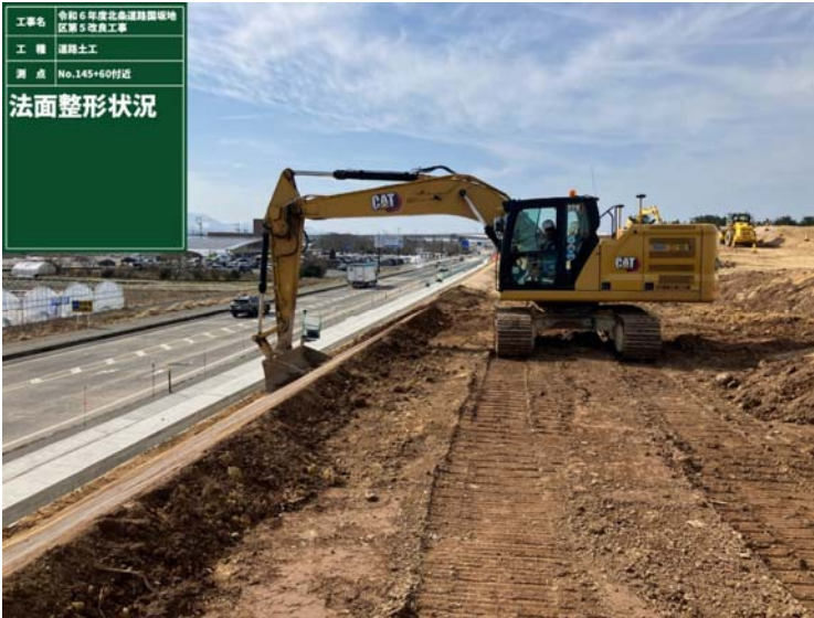
路体盛土工 法面整形状況
