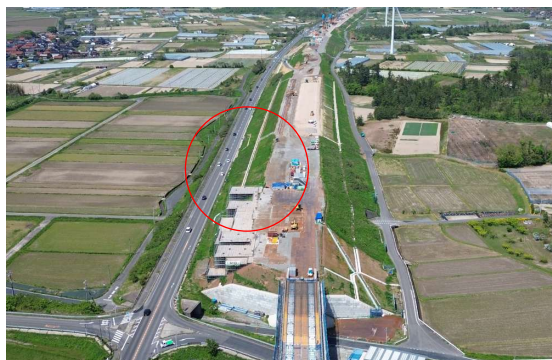
令和8年4月（地盤改良工完成済み）
