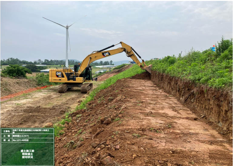
路体盛土工 段切り状況
