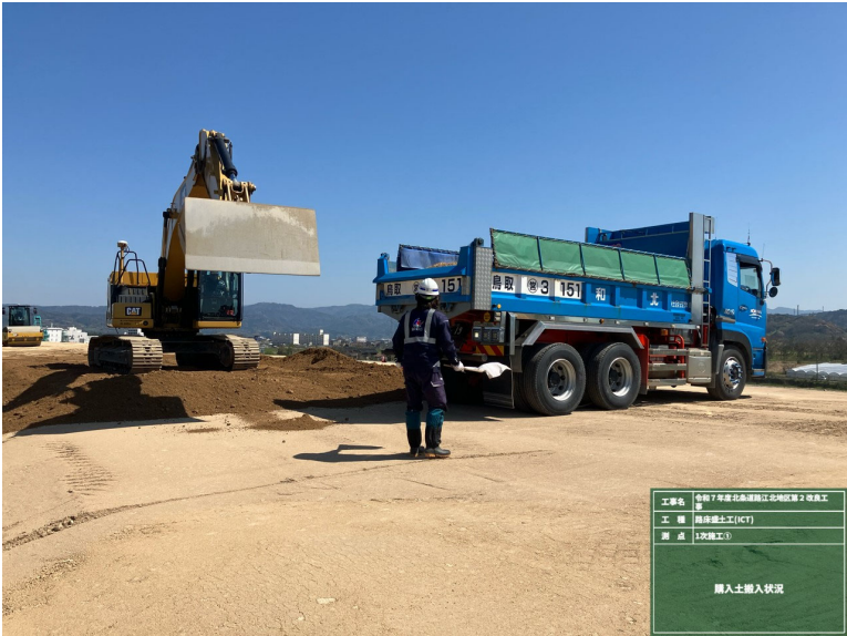
路床盛土工 搬入状況
