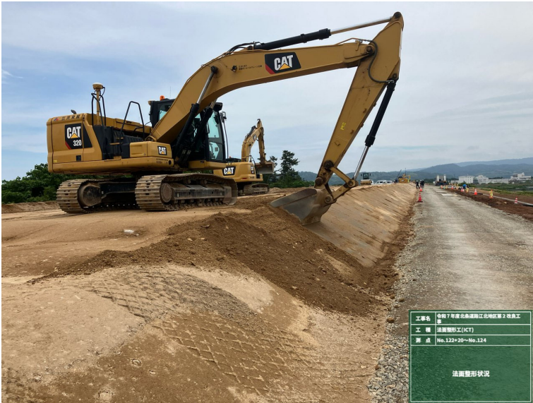
路床盛土工 法面整形状況
