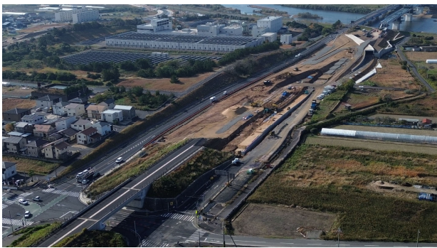
令和7年11月【着工前】
