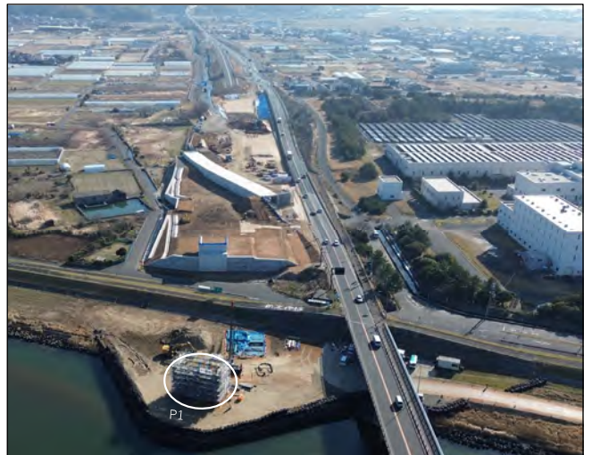
終点側（北栄町江北より）
