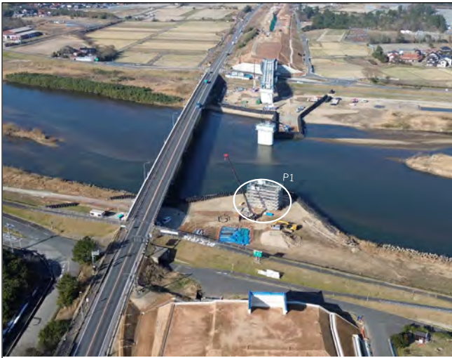
起点側（湯梨浜町はわい長瀬より）
