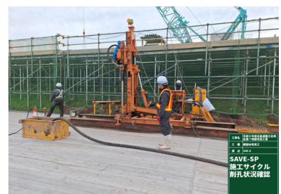
静的圧入締固め工法（SP工法）
