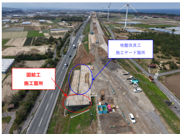
足場設置箇所
