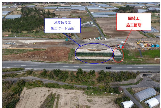
施工ヤード整地箇所
