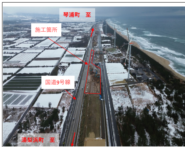
施工状況（松神）
