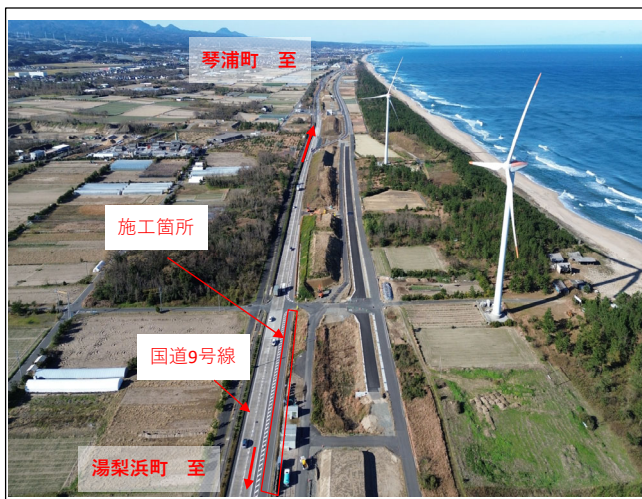
施工状況（松神）
