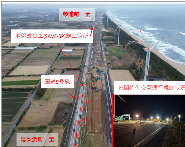
施工状況（松神）
