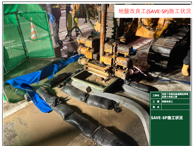
施工状況（松神）
