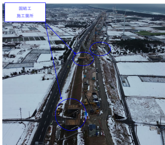
薬液注入箇所
