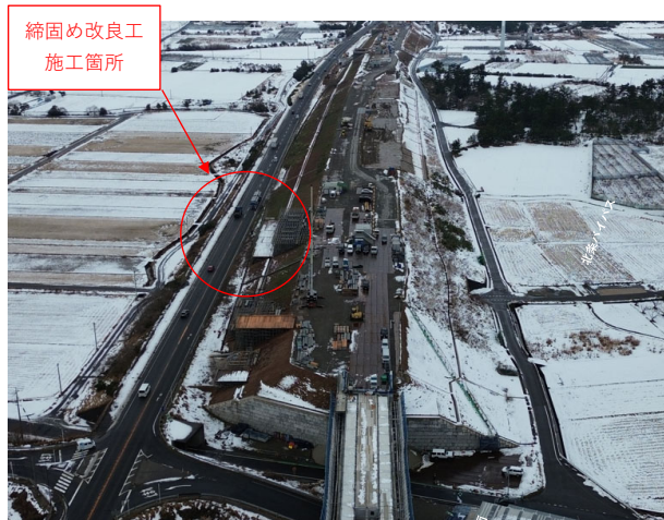
締固め改良工箇所
