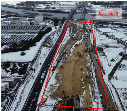
工事現場東側より撮影
