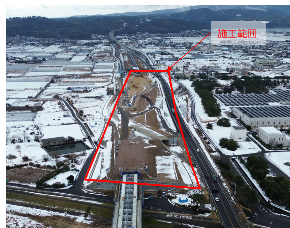
工事現場西側より撮影
