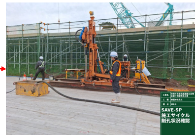
静的圧入締固め工法（SP工法）
