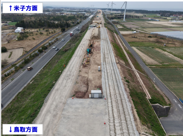
工事起点側(東)から撮影
