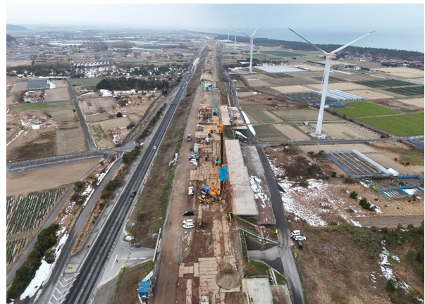
本体工事範囲 東側より
