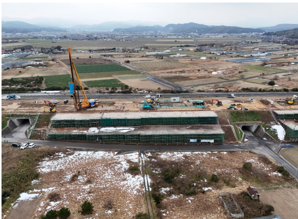
本体工事範囲 北側より
