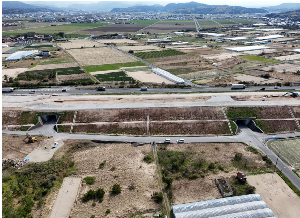
本体工事範囲 北側より
