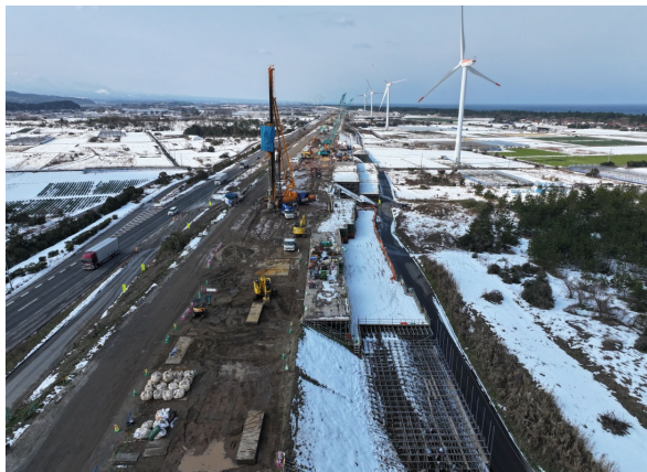
作業箇所 全景
