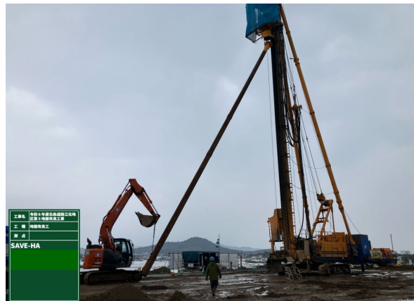
SAVE-HA 施工状況
