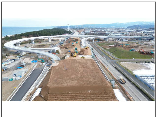
工事現場西側より撮影
