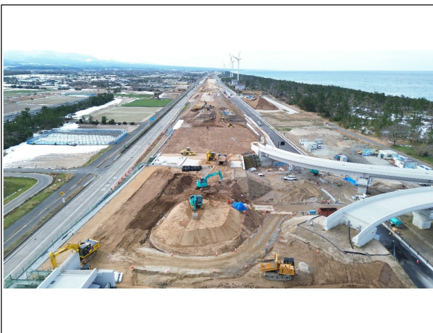
工事現場東側より撮影
