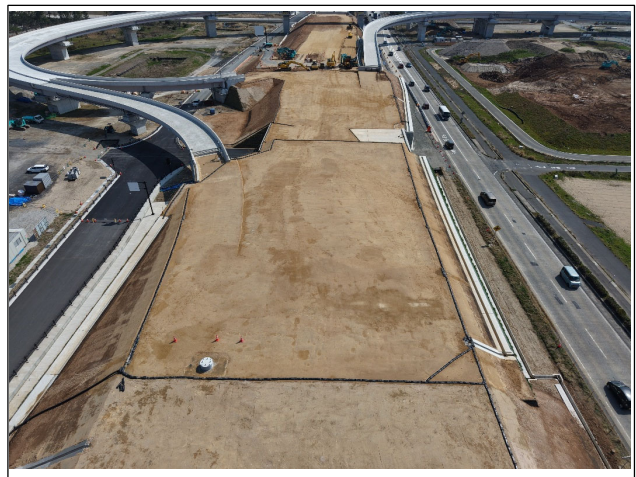
工事現場西側より撮影
