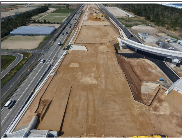
工事現場東側より撮影
