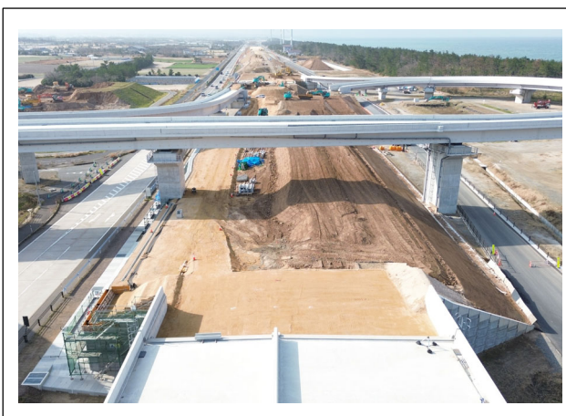
工事現場東側より撮影
