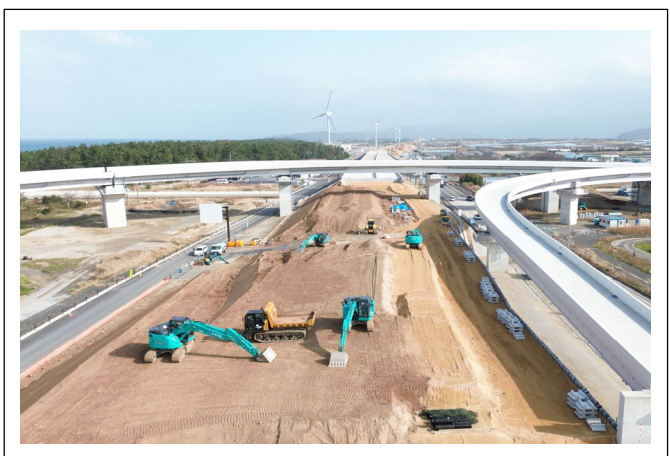
工事現場西側より撮影
