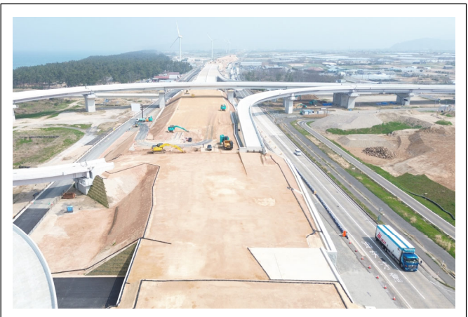
工事現場西側より撮影
