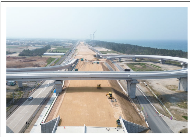
工事現場東側より撮影
