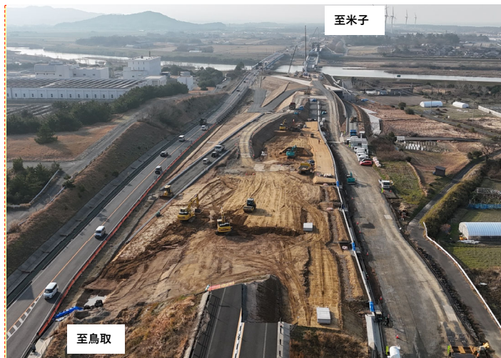
【起点側（東側から撮影）】
