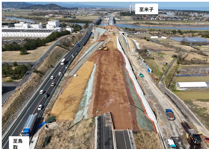
【起点側（東側から撮影）】
