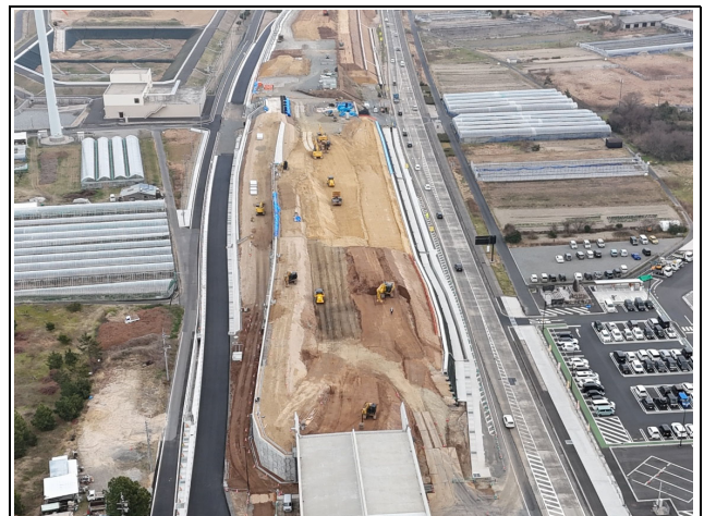
工事現場西側より撮影
