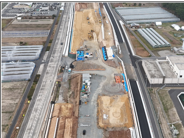
工事現場東側より撮影
