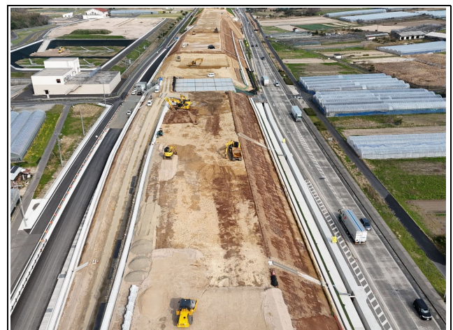
工事現場西側より撮影
