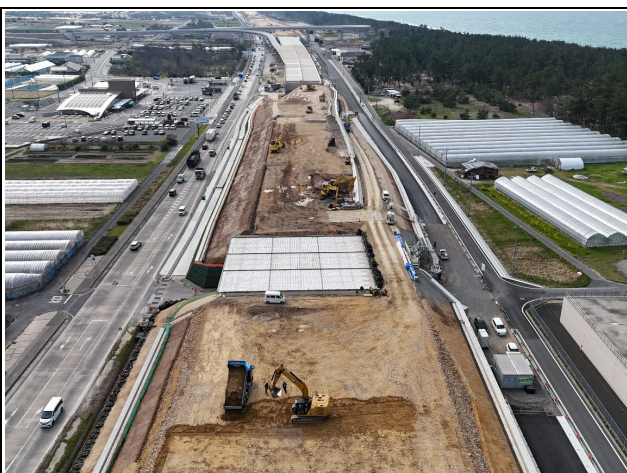
工事現場東側より撮影
