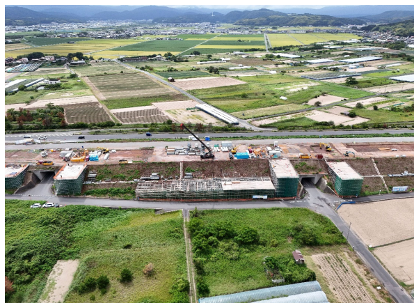
本体工事範囲 北側より
