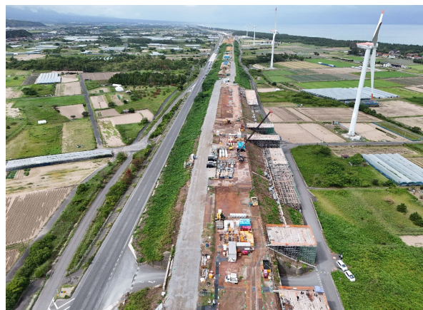
本体工事範囲 東側より
