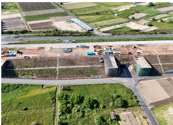
本体工事範囲 北側より
