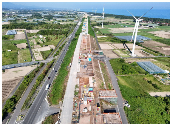
本体工事範囲 東側より
