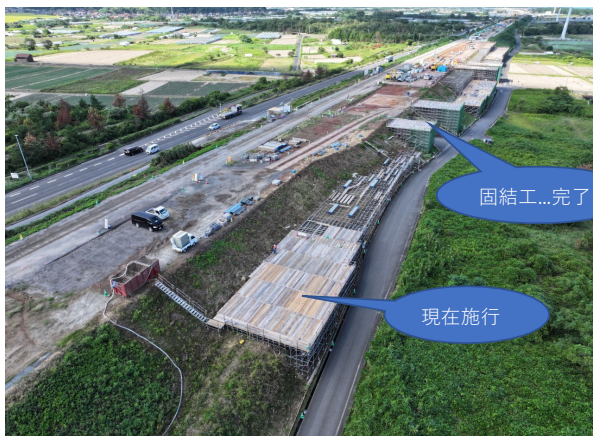
作業箇所 全景
