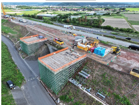
作業箇所 全景
