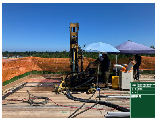
薬液注入工- 削孔状況
