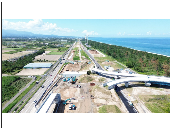
工事現場東側より撮影
