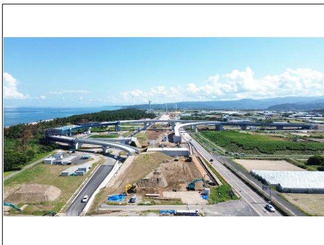
工事現場西側より撮影
