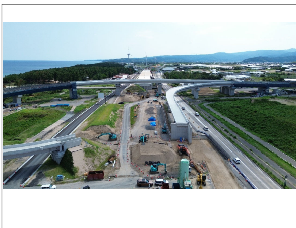
工事現場東側より撮影
