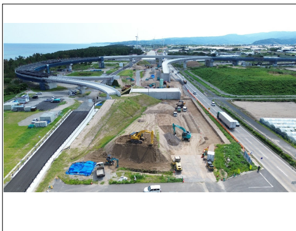
工事現場西側より撮影
