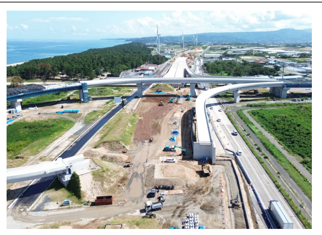
工事現場西側より撮影
