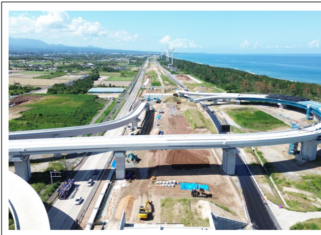
工事現場東側より撮影
