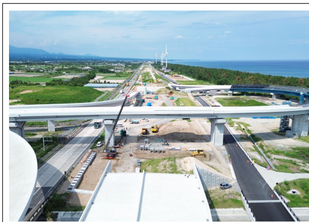
工事現場東側より撮影
