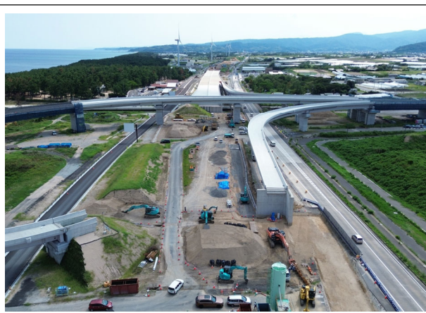
工事現場西側より撮影
