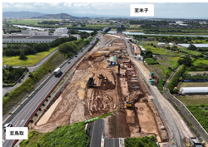
【起点側（東側から撮影）】
