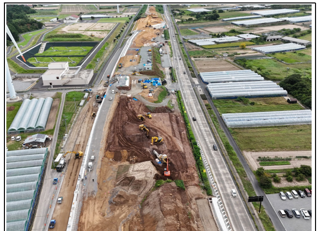
工事現場西側より撮影
