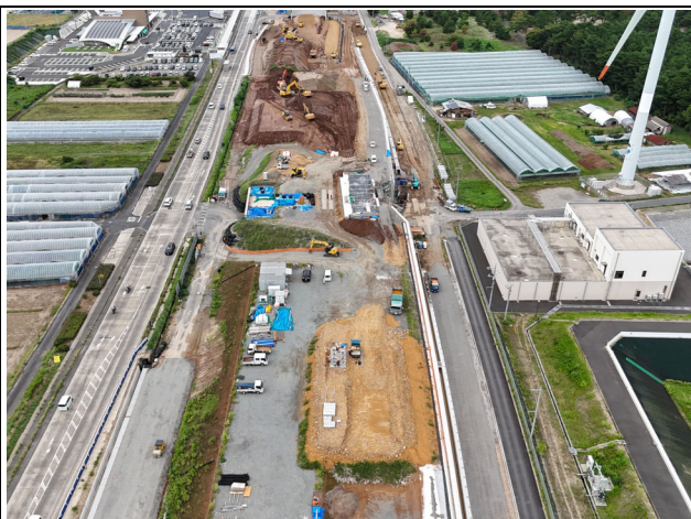
工事現場東側より撮影
