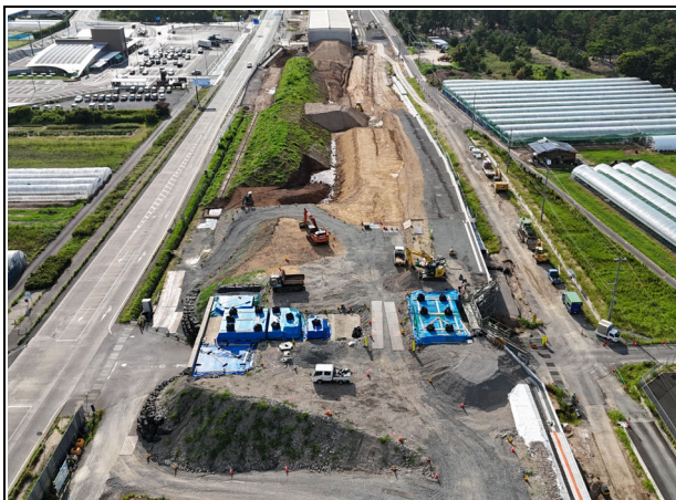
工事現場東側より撮影
