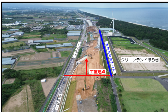
令和7年9月末（起点側より）
