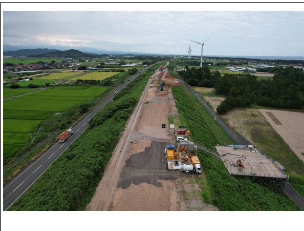
工事現場東側より撮影
