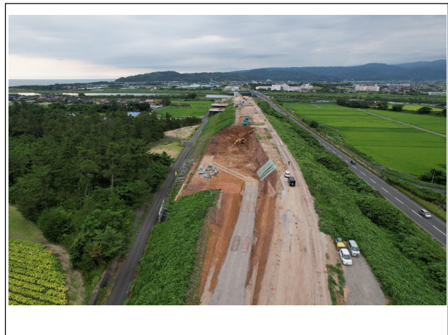
工事現場西側より撮影
