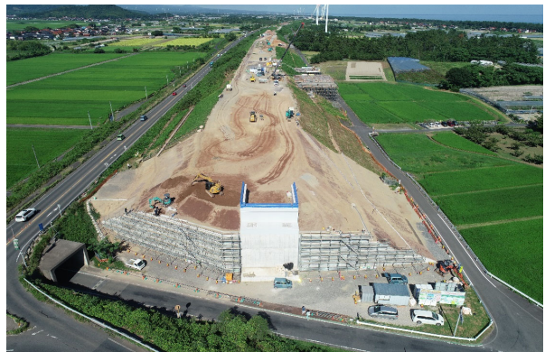
本体工事範囲 東側より
