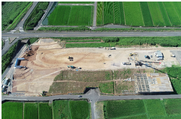
本体工事範囲 北側より
