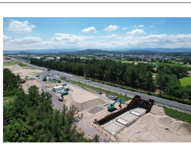
施工状況（1号場所打ち打函渠）
