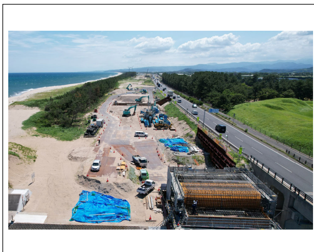
施工状況（A1橋台）
