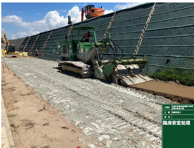
路床安定処理-セメント混合状況
