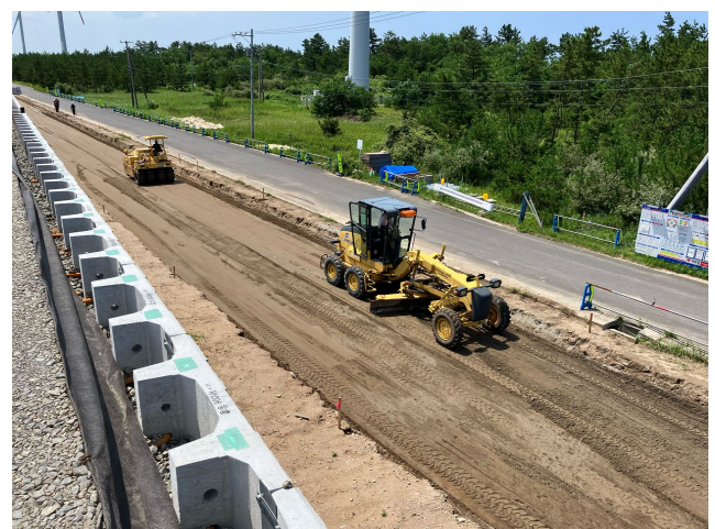
路床安定処理-路床整正状況
