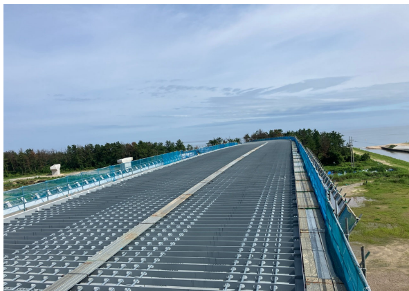
合成床版架設完了
