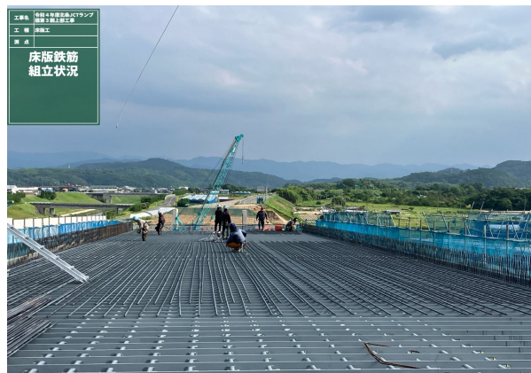
床版鉄筋組立状況
