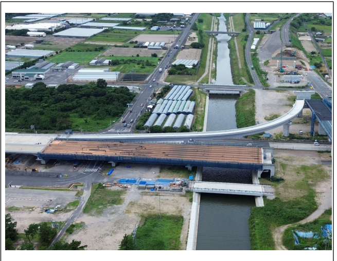
施工状況（海側より）
